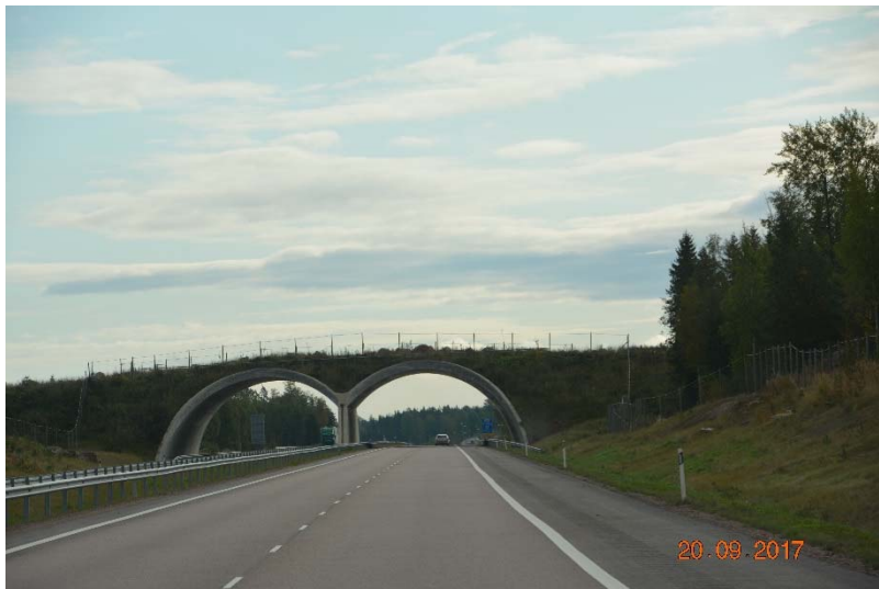
Figur 8 Tunnel og bru, med kallenamn «Mc`Donalds-tunnelane»
