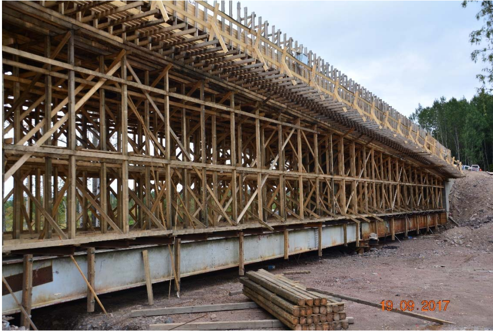
Figur 5: Reisverk av trevirke for brukonstruksjon
