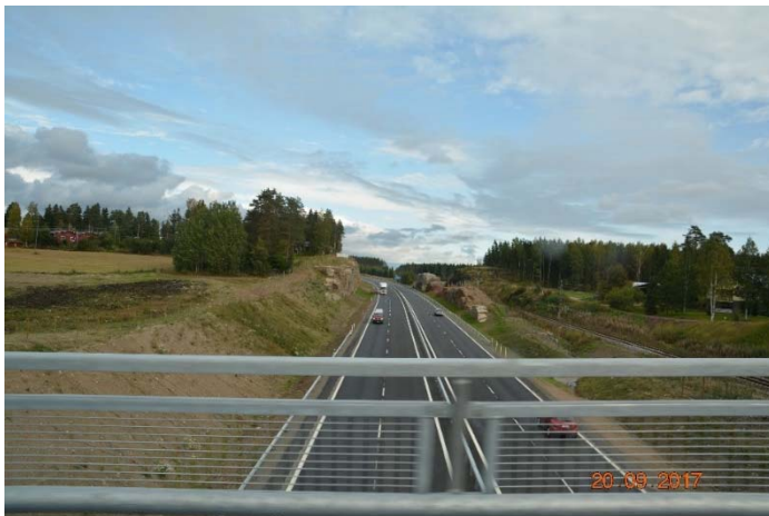
Figur 14 Motorvegen ved sida av jernbana, og det som vart omtala som ein «utfordrande» fjellknaus.
