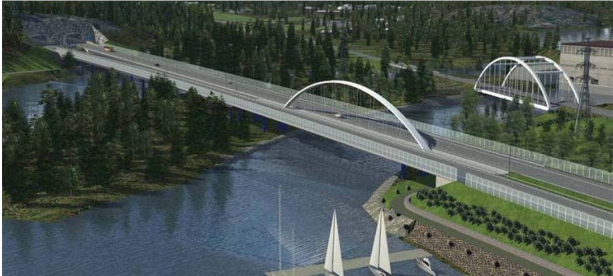
Figur 9 Bru på prosjektet, som hadde ein lang prosess for å avgjere bruløysing pga eigedom og løysing.
