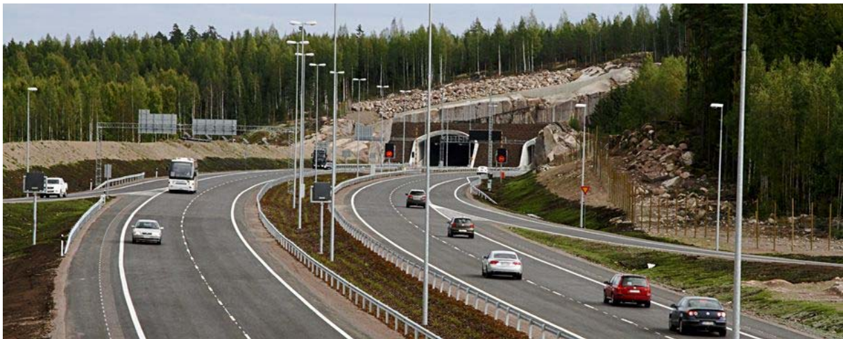
Figur 10 Oversiktsbilde over motorvegen og tunnelen
