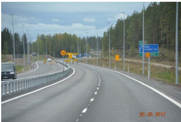
Figur 15 Siste del av anlegget før ferdigstillelse.
