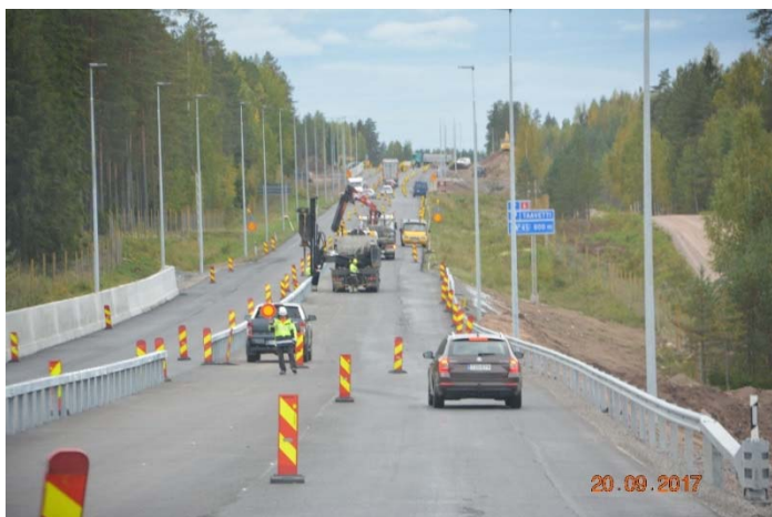
Figur 16 Montering av rekkverk
