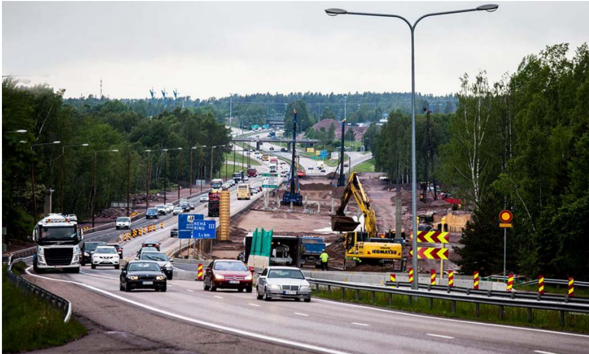
Figur 3: Bilete frå byggeplass
