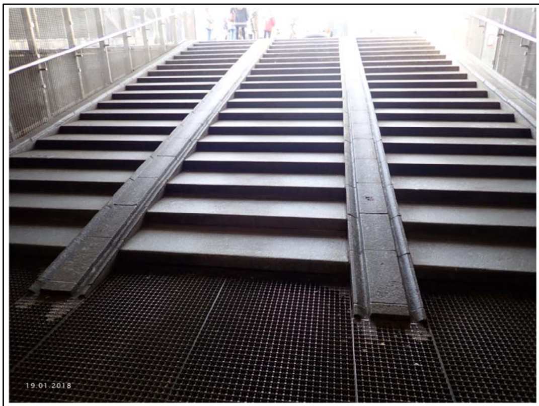
Trapp i stein. Nydelig. Stein med «hjul spor» for å lede sykkel opp/ned trappene
