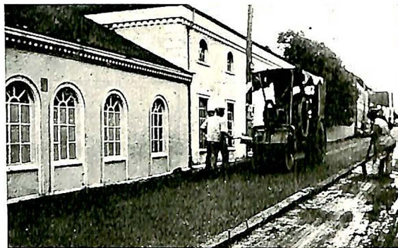
Veien Stavanger—Sandnes, i Hillevaag. Valsning av semi-grouting med Koldmex, sept. 1927.
