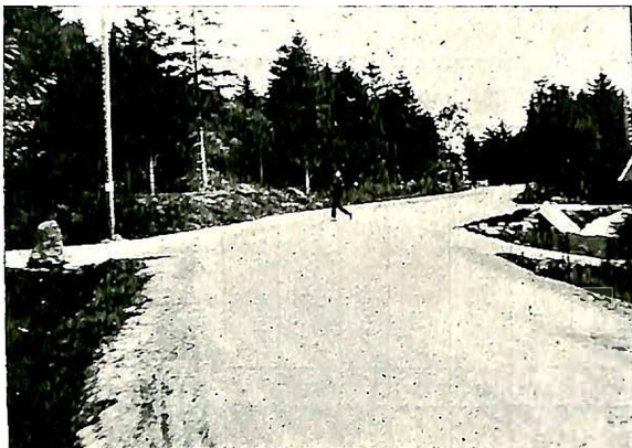
Veien Stavanger—Sandnes ved Hinnakrossen. Overflatebehandlet sommeren 1927, forrest med asfaltemulsjon, bakerst med tarvia A.
