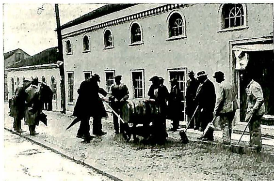
Veien Stavanger—Sandnes, i Hillevaag. Påføring av Koldmex.
