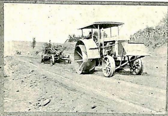
Fig. 22. Høvling av planeringen.
