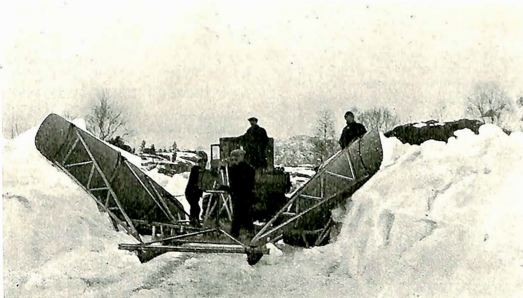
Fig. 2. Snorydning på Kvinesheia. Største bakplog 4 m breitebredde, 2 m høie rømmevinger.
