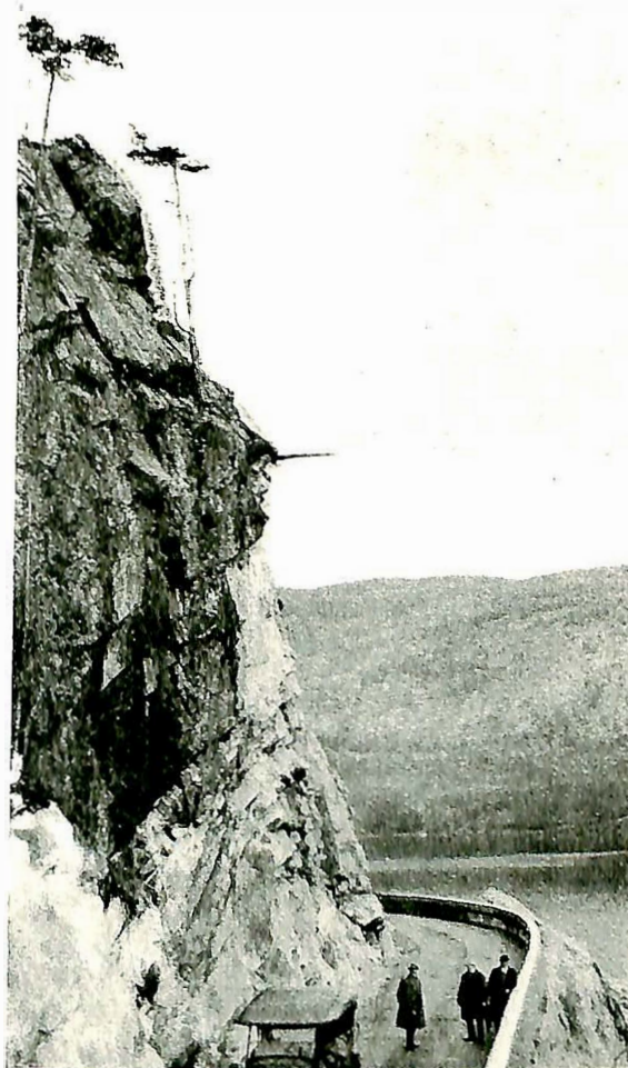
Fig. 5. Betongrekkverk i Telnesbakkene, Telemark fylke.
