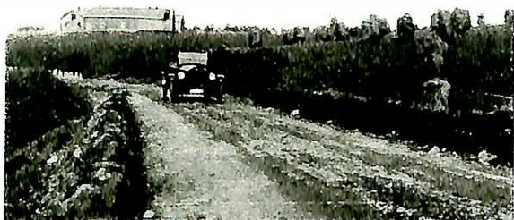
Fig. 11. Jordvoll-rekkverk, Sor-Trøndelag fylke.
