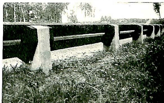
Fig. 16 og 17. Rekkverk med skråttstilte rekker. Akershus fylke.
