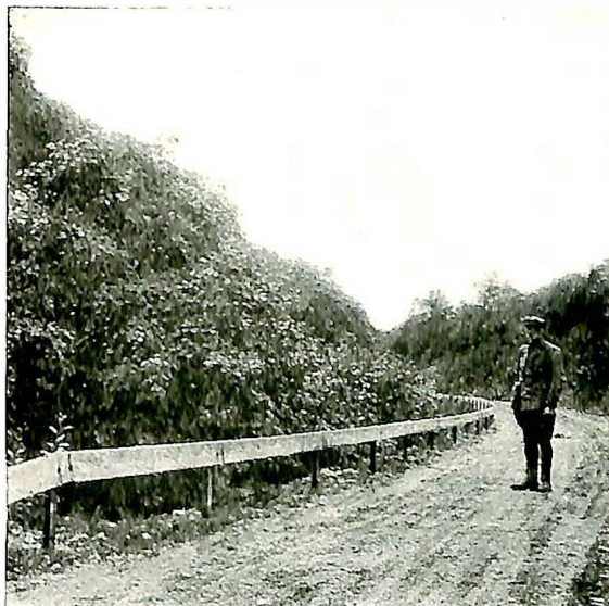
Fig. 10. Lavt rekkverk 0,55 m høit med jernstolper (skinner). Sør-Trøndelag fylke.
