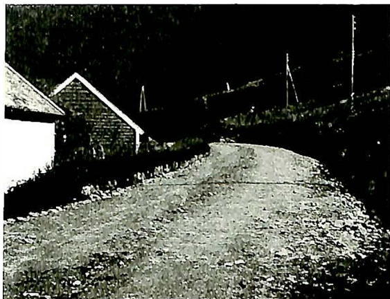
Fig. 9. Rekkverk av jord med flate stenheller på inner-siden, Hordaland fylke.
