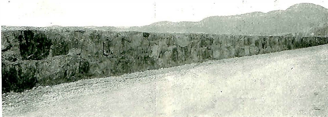
Fig. 13. Rekkverk av bruddsten i cement, Nord-Trøndelag fylke.
