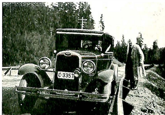
Fig. 18. Rekkverk med skråttstilte rekker, Akershus fylke.
