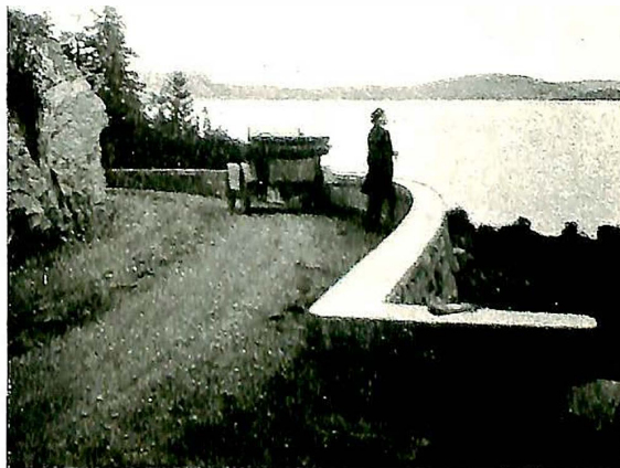
Fig. 12. Rekkverk av småsten i cementmørtel, Nord-Trøndelag fylke.
