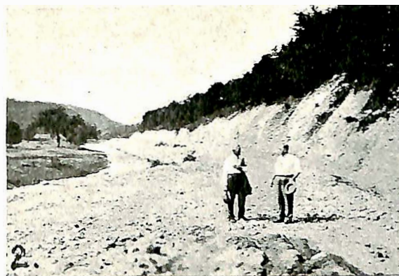
Fig. 2. Ferdigplanert vei. Bemerk de bratte skjæringskrøininger.
