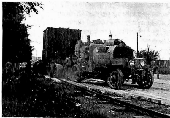
Fig. 6. Transport av transformator til Moholt.
