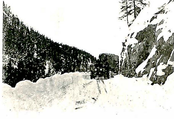
Fig. 11 og 12. Transport av generatorkolli, vekt 19 ton, paa vinterføre.
