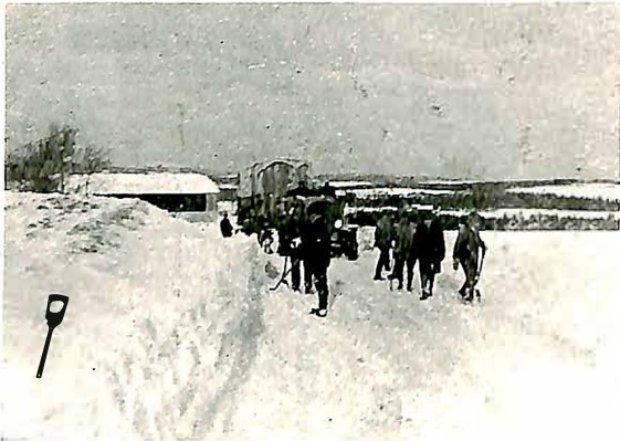
Fig. 11 og 12. Transport av generatorkolli, vekt 19 ton, paa vinterføre.
