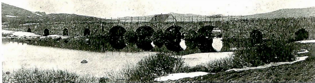
Fig. 6. Skjæveland bro i Høyland og Klepp.
