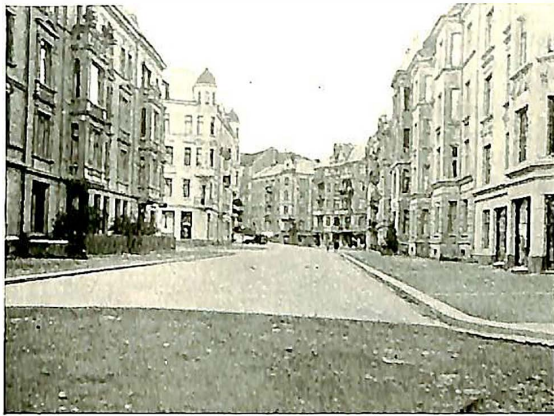
Thomas Heftyes gate, Oslo, efter lægningen av betongdækket.
