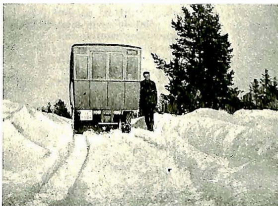
Parti av veien mellom Elverum og Trysil.
