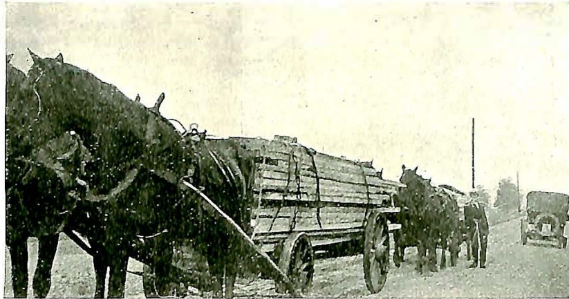
Fig. 1. Plankelas indover hovedveien i Berg til Fredrikshald. Ca. 2,2 ton lasvekt paa 4 hjul med 6,3 cm fælgbredde.
