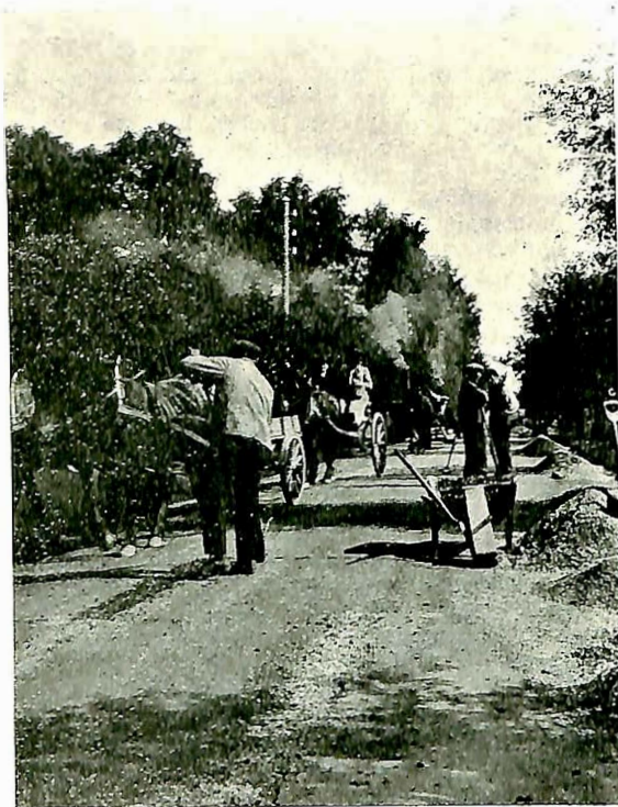
Fig. 9. Overflatebehandling av veien Berg—Fredrikshald. Utbedring av feil sommeren 1924. I 4.0 bredde derefter anbragt et asfaltbelæg ca. 2.0 l pr m 2 .
