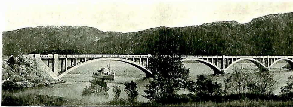
Fig. 12. Broen seet fra nedsiden.
