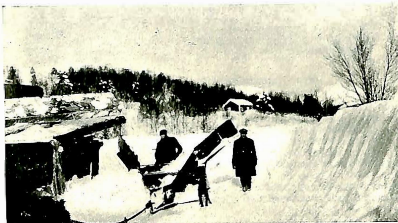
Fra Battenfjordsfjeldet. F. W. D. bil og plog. Opromning.
