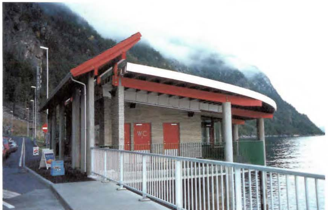
Servicebygg, Mannheller Ferjeleie, Sogn og Fjordane. Eksempel på utradisjonell, "skreddersydd" formgivning (Arkitektkontoret 4B a/s, Sogndal).
