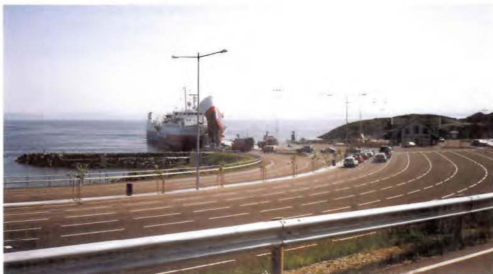
Oversiktlig og velordnet ferjeleie. Trerekken er klargjørende for skillet mellom kjøring til og fra ferja og vil berike anlegget når den vokser til (Arsvågen, Rogaland).
