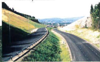
Ned mot Mjøndalen
