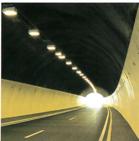
Tunnelene har lyse betongelementer på veggene
