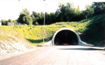
Tunnelportal i Bjørkelia
