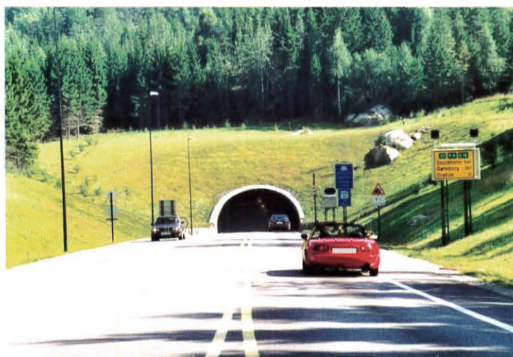
Oslofjordtunnelen - fra Hurumsiden.
