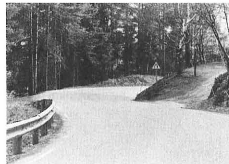
Farlig skoleveg, Juksevelta Riksveg 360 (skal utbedres).
