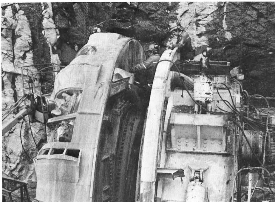
Demontering av maskinen. (Foto: K. Berglund)
