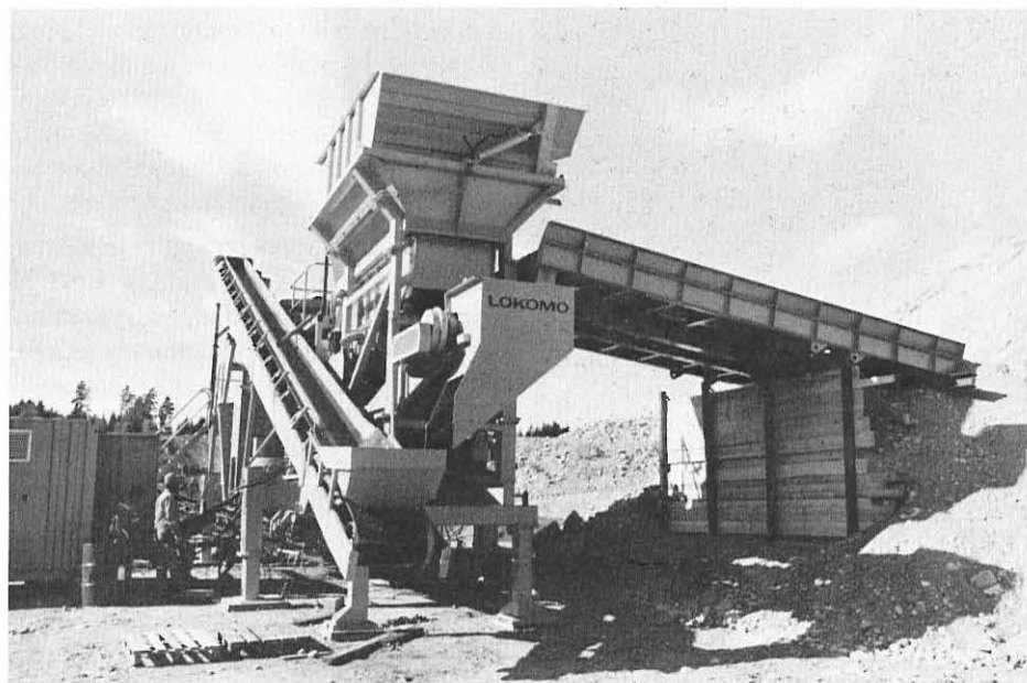
Knuseverket ferdig montert. (Foto: W. Scott-Fjære)
