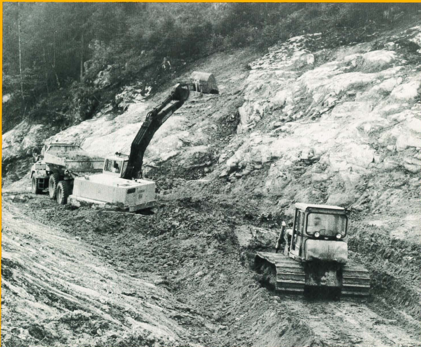
Vanskelig anleggsarbeide på Rv. 36 i Mælum, hvor grunnforholdene er svært problematiske. (Foto: B. Aase)
