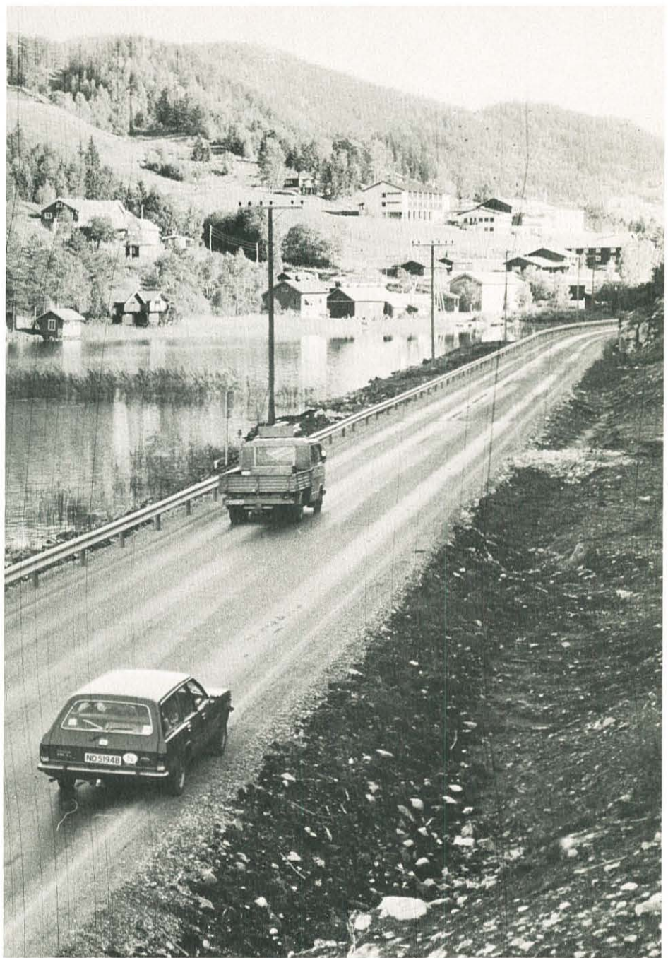
Den nye vegen på Vest-sida av Morgedalstjønni har god bredde til forbikjøring. Her sett fra Nord-sida mot Morgedal sentrum. (Foto: Fred Ø)
