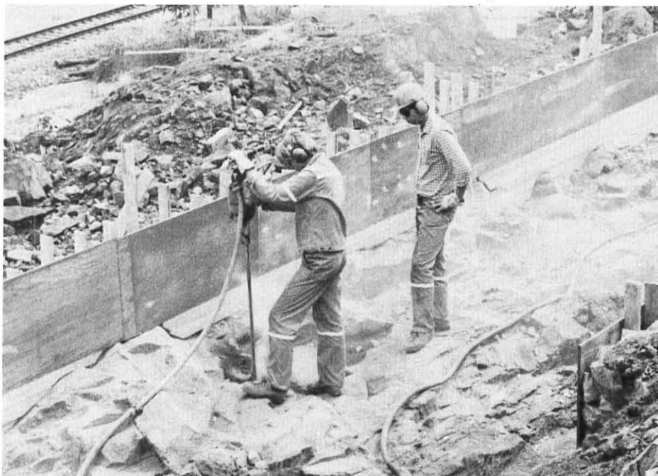
To av sommervikarene har borejobb på anlegget i Porsgrunn i ferien. Ole Robert Grava (til venstre) og Geir Halvor Sollid.
