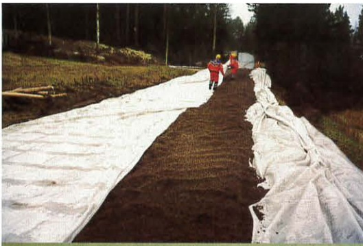
Lecamassene pakkes inn i fiberduk før bærelag og asfalt legges over.
