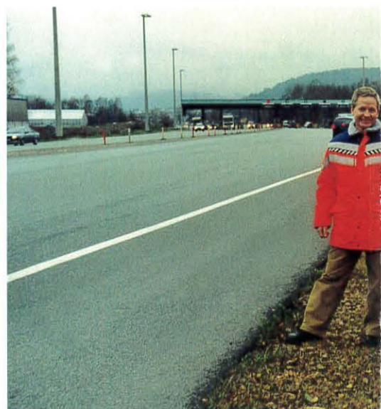
Prosjektleder Kai Midtskogen og prosjektmedarbeider Mill-Hege Gravem planlegger istandsetting av området ved Kjellstadbommen.
