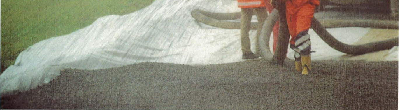
Grått og støvete da lecakulene ble blåst ut på Fv 133. Spesialproduksjons Olav Kjærnås er "slangetenner".
