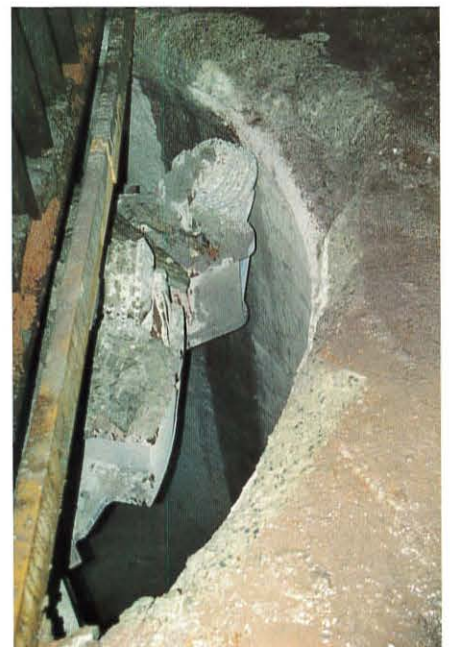
Luftesjakten: 4,04 m bred og 182 m loddrett ned.
