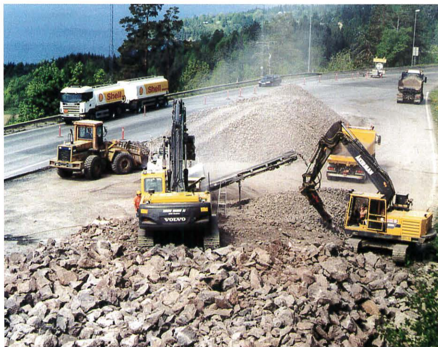
Knuseverk for pukke på Skaret. Stein fra fjellet langs E 16 som er sprenget ut bare 400 meter unna.
