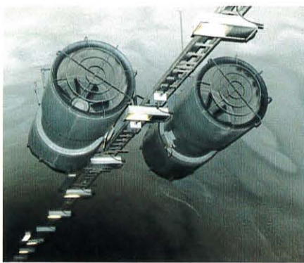
34 kraftige, reversible vifter som dette skal sørge for god gjennomlufting og frisk luft i tunnelen.
