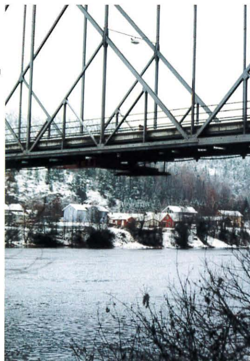
Høyt oppunder Skotselv bru henger reparatører fra Statens vegvesen Buskerud.
