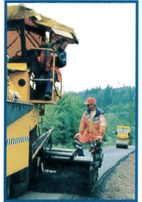
Torstein Bergaplass (sittende) og Bjørn Melbye legger ut det første dekke-laget. Bjørn Westby følger etter i komprimeringsvalsen.
