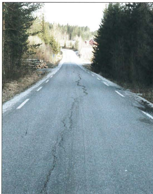
Telesprekker er en hyppig skadetype på fylkesvegene.
