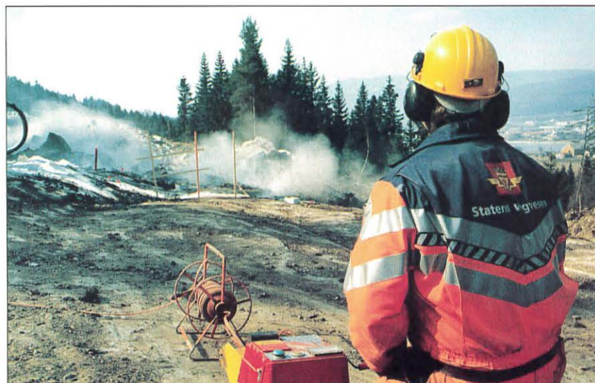
Skytebas Knut Grønli drar av nok en salve for å flate ut terrenget på rv 11-anlegget på Bangeløkka.
