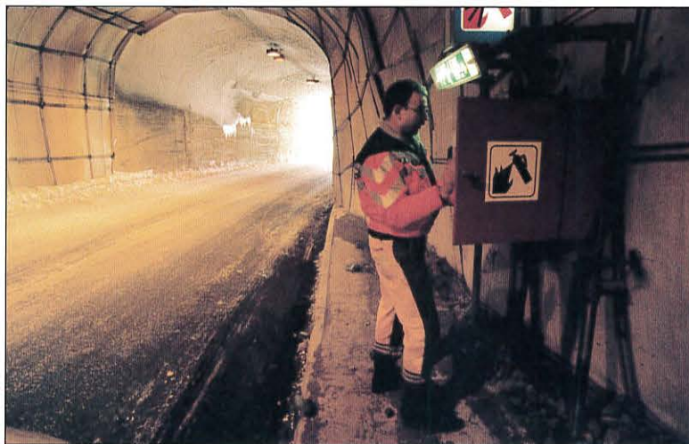
Sikkerhetssjekk i Geiterygg-tunnelen på rv 50.
