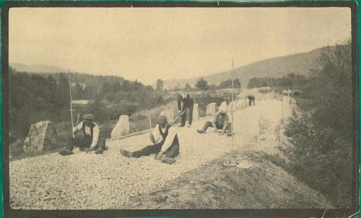
Steinpukking av vegbanen.
