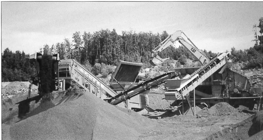
Knuseverket rigget opp ved Foksrød i Vestfold. Selve asfaltknuseren midt i bildet.
