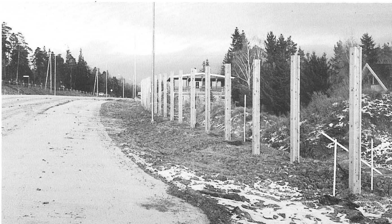
Vegvesenets egne mannskaper vil i vinter produsere og sette opp støyskjermer langs den nye parsellen.
