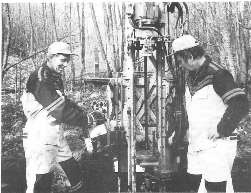
Anders og Svein i jobb med ei boring.
