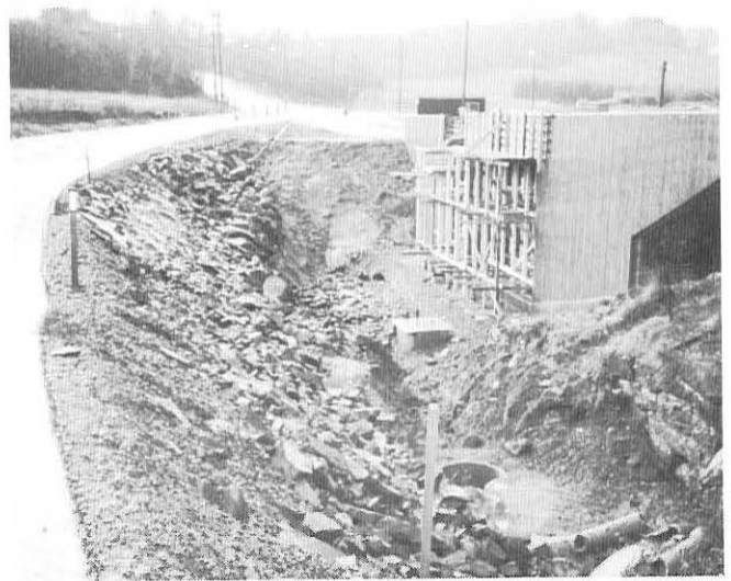
Omkjøringsveg og brukonstruksjon ved Botilrud. (Foto: H.Ø.)
