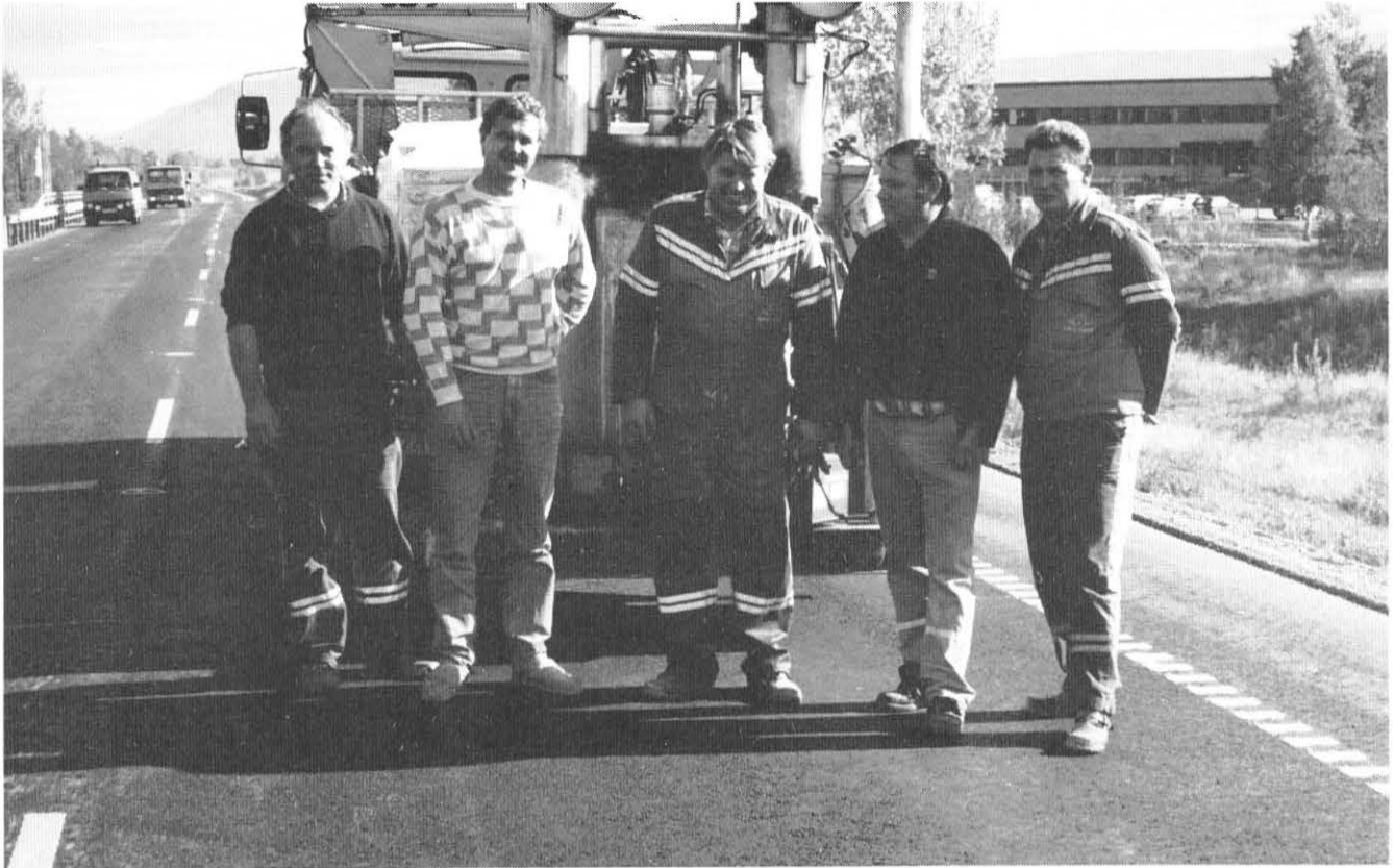
Skilt/merkegjengen. Fra venstre: Arbeidsformann Bjørn Kristoffersen, oppsynsmann Øystein Johansen, Vidar Hansen og Svein Nilsen. Til høyre: Per Arne Syvaldsen, gjengens verneombud.
