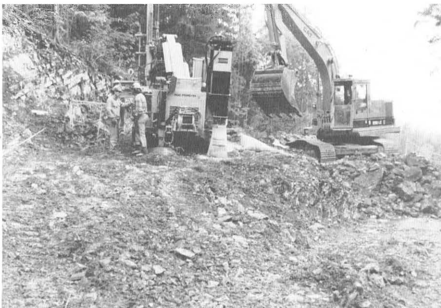
«Gutta» i sving med borryggen, mens gravemaskinen rensker opp etter foregående salve.
