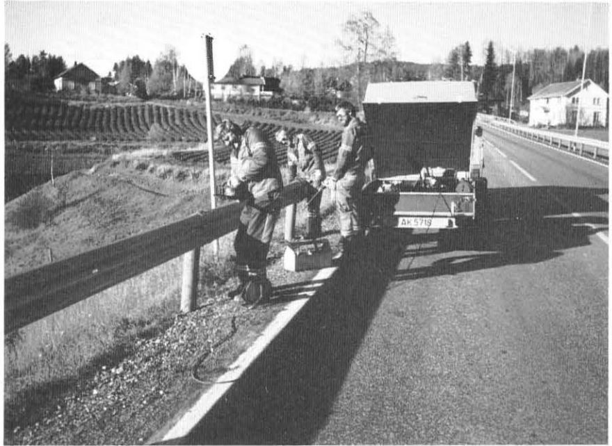
Rekkverkmontering på riksveg 8. Fra venstre: Harald Vårviken, Marthin Harangen og Jacob Fogstad.
