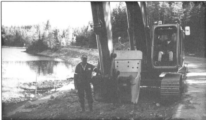
Arbeidsformann Tor Ole Dokken. Gravemaskinen er privateid, med Terje Sollid ved spakene.
