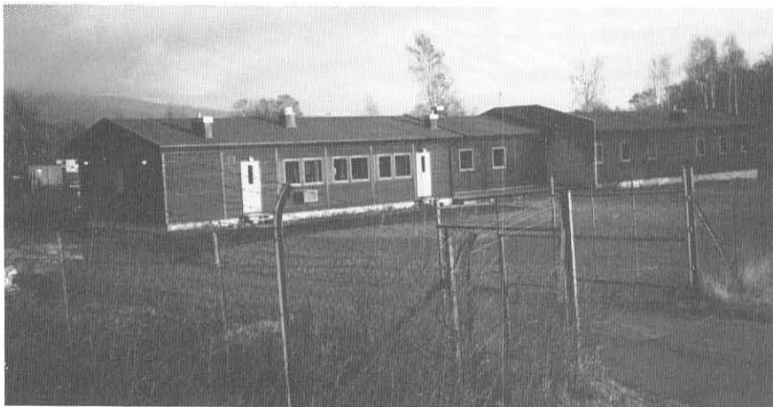
Brakkeforlegningen ved Solberg vegsentral.
