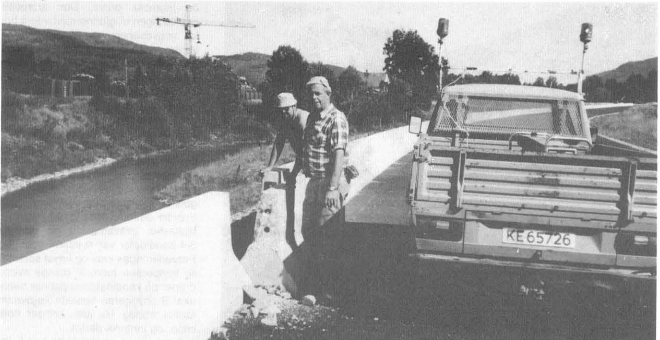
Tore Sogn og Kåre Hansen setter betongelementer som støyskjerming.
