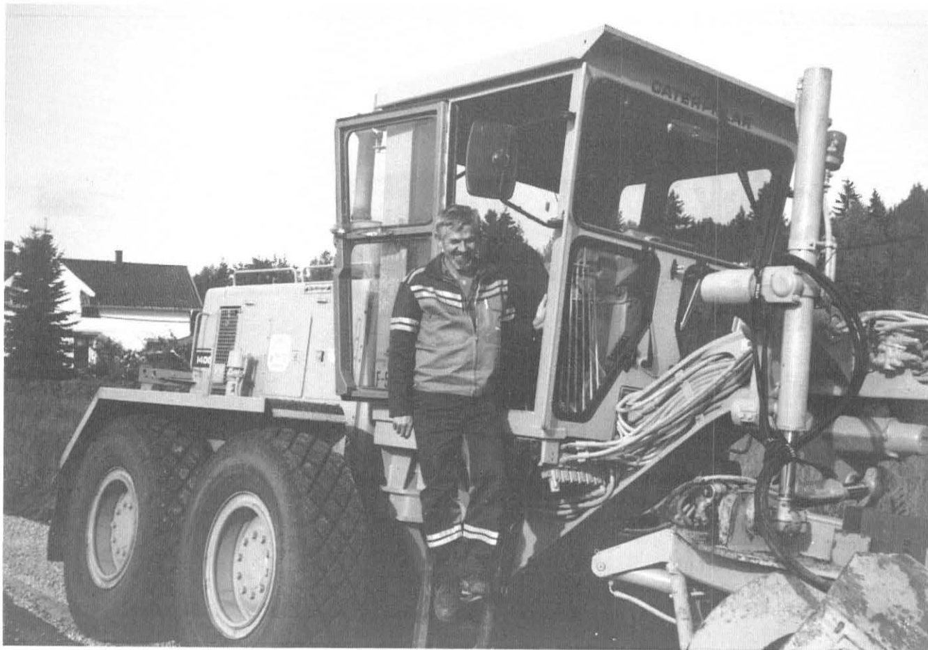
Bent Sørensen tar finpussen etter fresinga.
