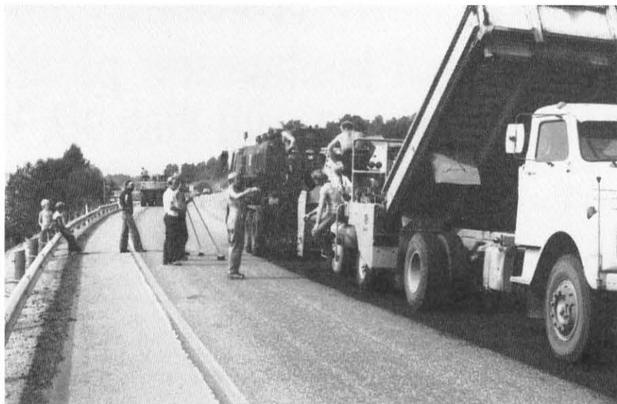
Spesielt asfaltarbeiderne har en utsatt arbeidsplass.
