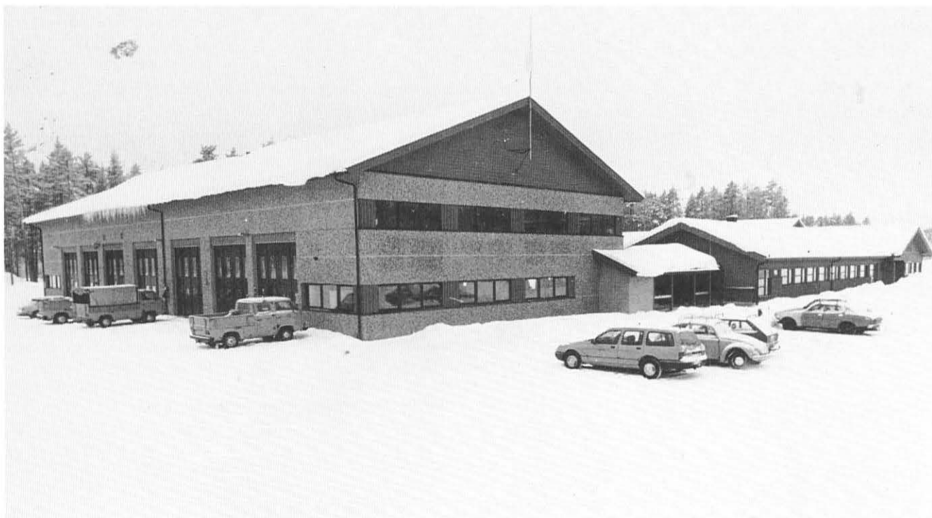
Den nye kombinerte veg- og biltilsynsstasjonen dekker et areal på 2.300 m 2 , og byggekostnadene ble ca. 19 mill. kroner. (Foto: Per Erik Knive.)
