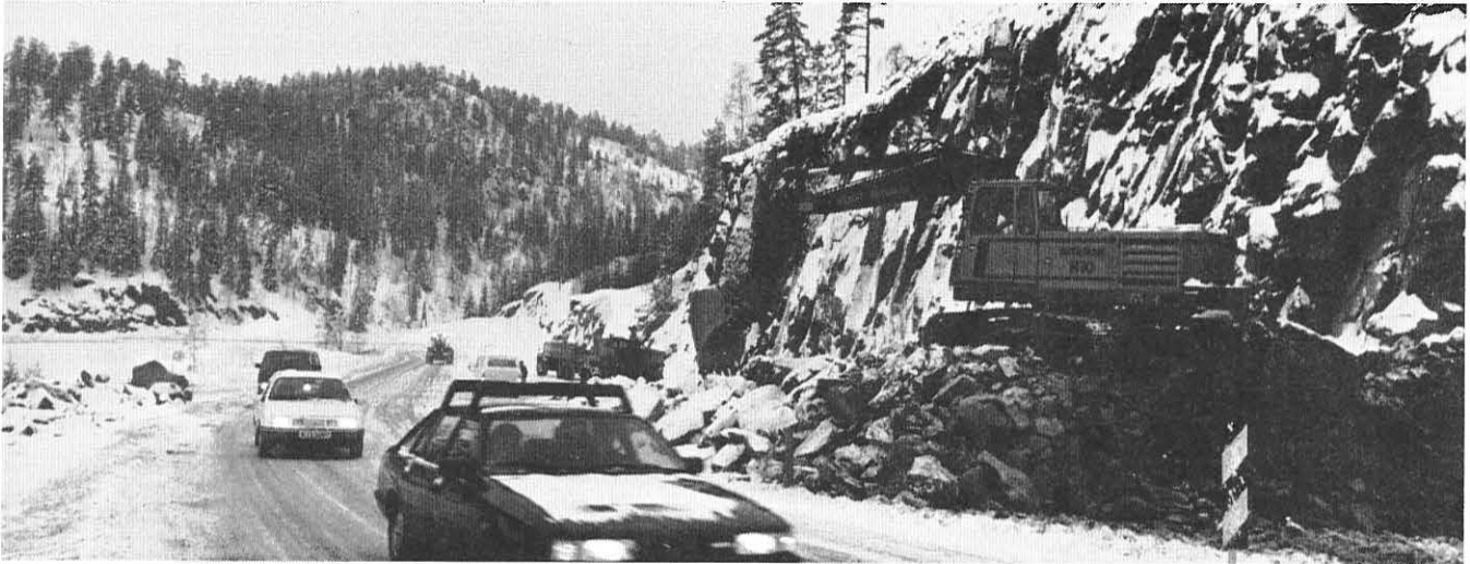
Arbeidet som nå pågår på E-68 består av sprengning av 25 000 m 3 fjell. Omlagningen av vegen ved Skaret vil være avsluttet innen utgangen av året. (Foto: Per Erik Knive.)
