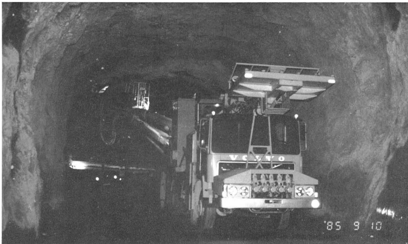
Riggen i arbeid i tunnelen. (Foto: Tore Braaten.)
