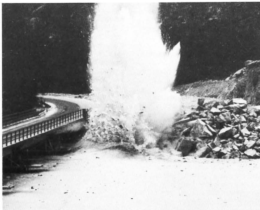
Ved den spesielle løsningen som ble valgt for den nye Mørkvann bru, sparte vi omkring 1,6 mill. kroner.
