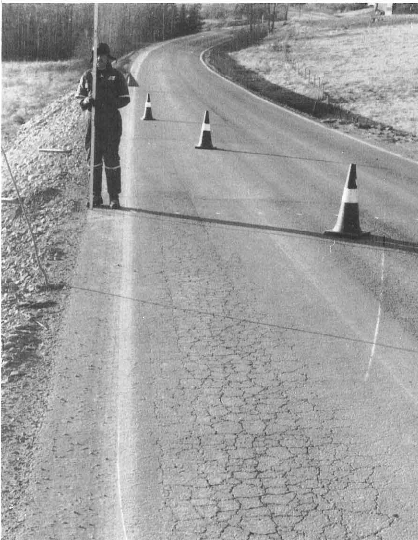
Et «godt» eksempel på hva som skjer dersom bærelaget ikke holder mål.
