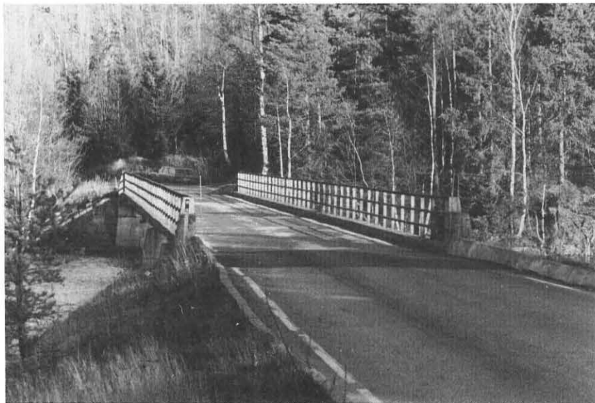
Arbeidet med ombyggingen av Mørkvann bru er så vidt startet opp. Ny bru vil stå ferdig 1984/85. Foto: W. Bakken
