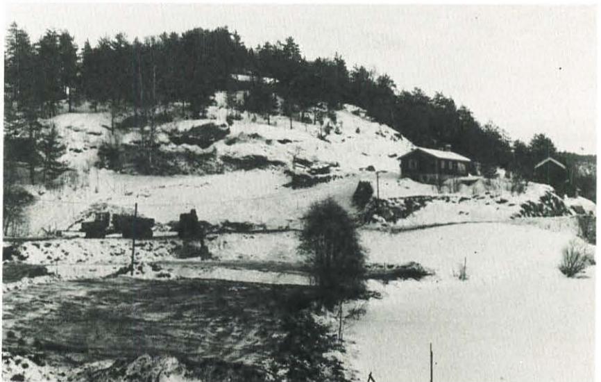
Avlastningsområdet, kryssingen av eksisterende veg og bebyggelsen som innløses. Foto: Skogen.
