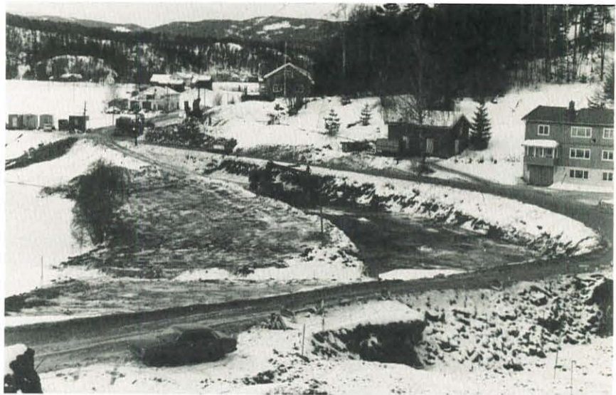
Trauing for ny veg, avlastningsområdet og den delen av Simoa der motfylling/erosjonsplastring skal anbringes. Foto: Skogen.
