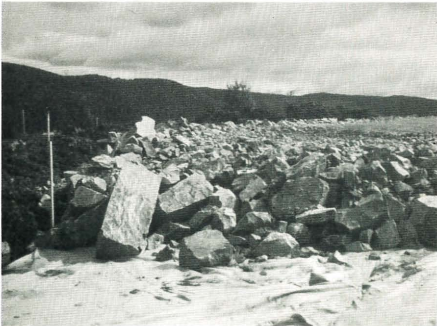
Forsterkning av vegnettet er en viktig oppgave for vegvesenet i framtida.
