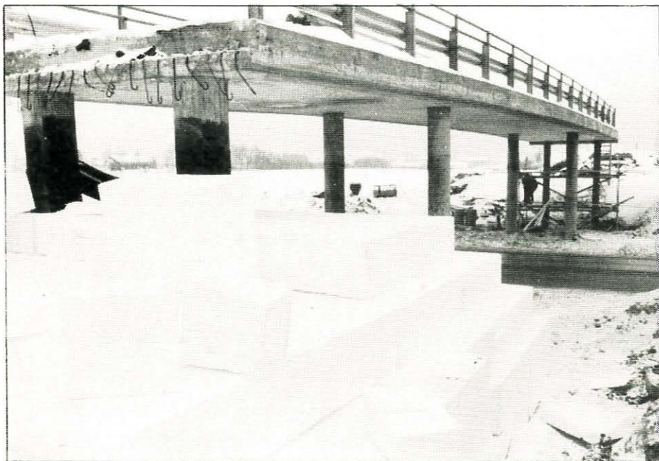
Her er barken blitt fjernet og blir så erstattet med mer moderne «masser».
