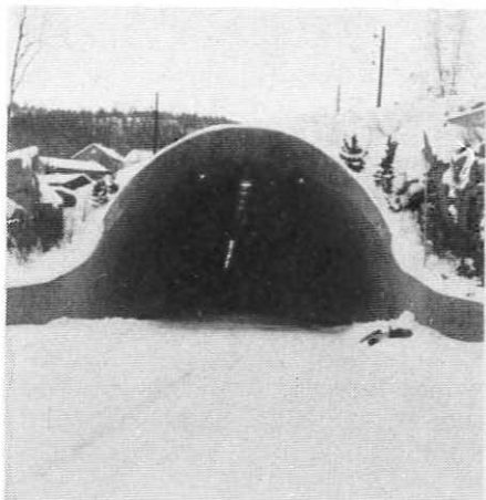
Den 550 m lange tunnelen er den første i sitt slag i Norge som i inngangssonene har belysning etter motlyspriusippet.
