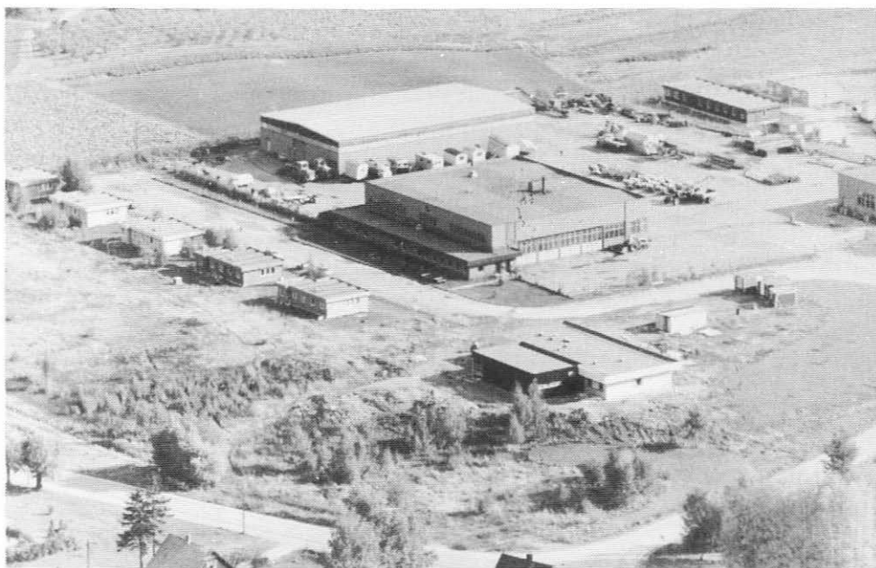
Det nye laboratoriet passer godt inn i det øvrige anlegget på Solbergmoen.
