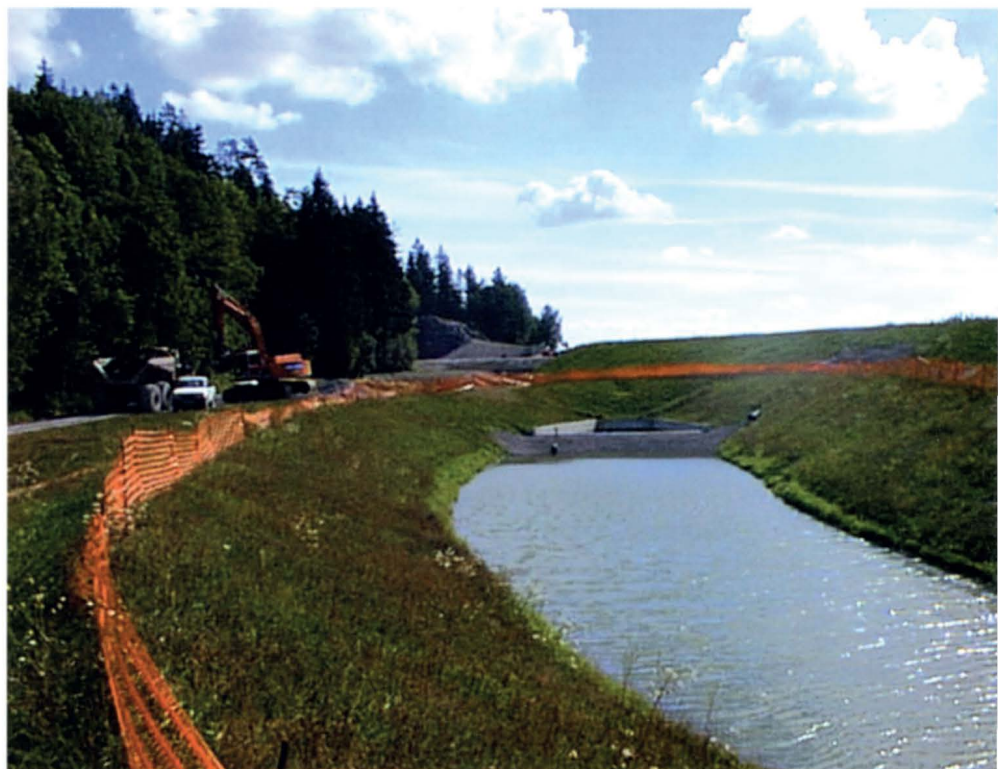
Et av bassengene langs nye E18. Ryktene vil ha det til at vegkontoret har tenkt å bruke bassengene til oppdrett av laks for å spe på de reduserte bevilgningene til Vestfold.
