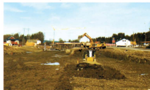
Det trengs stor plass når en fire-felts motorveg bygges. Her fra sydsiden av Kopstad-krysset
