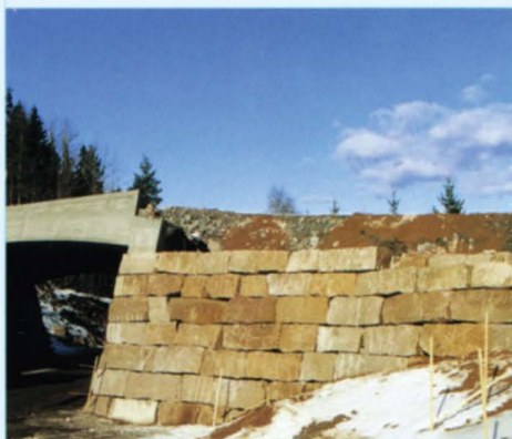
Vegen på hver side av tunnelen skal harmonere med narurlandskapet. Her er en detalj fra brukarene som forskjønnnes med lokal Røykengranitt.
