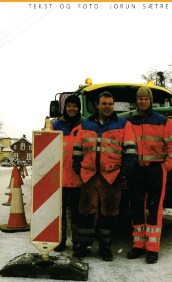
Vestfolder'n fant Kim Steinholt og hans firma på Barkåker, mens de utførte vegarbeid for Telenor. Det bemerkes at skiltingen var tilfredsstillende.
