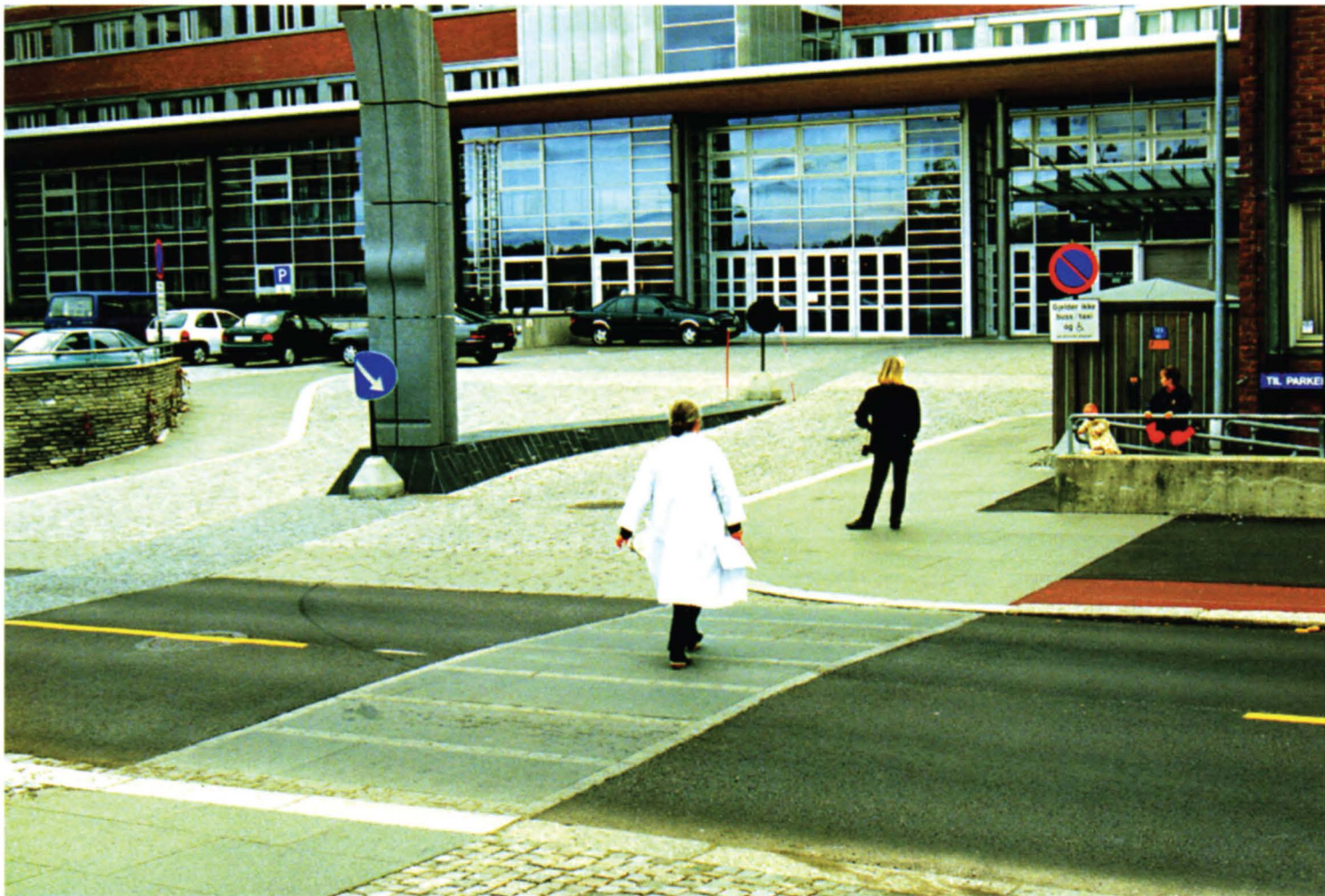
Gangfeltet foran sykehuset består av innfelte granittheller. Som bildet viser er det lite fargeforskjell fra asfalten rundt. - Hvis det blir et problem for trafikksikkerheten, må vi gjøre noe med det, sier Eva Preede.
