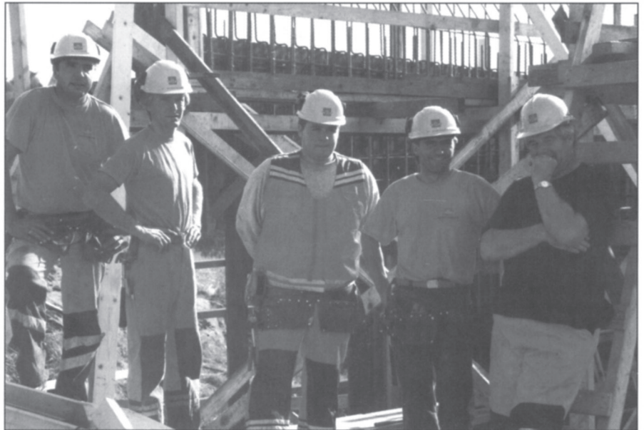
Landkar til bru over riksvegen er under bygging. Brugjengen med Helge Sogn (t.h.) F.v. Jostein Olsen, Tore Dybendahl, Vidar Thoresplass, (lærling), og Roger Strand.
