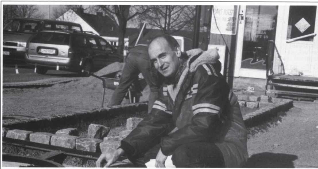
- Vi er godt i gang med arbeidene i Nedre Langgate i Tønsberg, forteller Lasse Sondbø. Steinsetting og beplantning vil sette en spiss på miljøgata, som er ferdig til St. Hans og ferietid.
