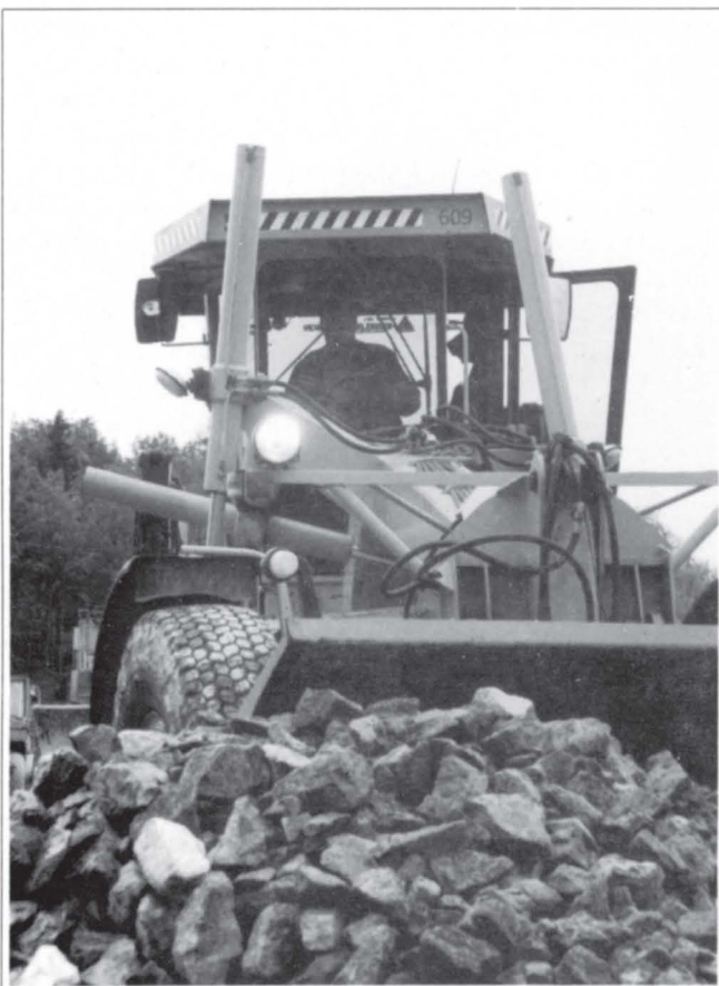
Over: Høvelfører Oddmund Nilsen i full jobb med oppretting ved motorvegbrua på Bergsenga.
