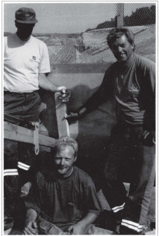
Deler av brugjengen er her i ferd med å gjøre finpussen på bruene over jernbanen på Bergsenga. F.v Arne Hansen, Tom Erik Hansen og Harald Bøvre.
