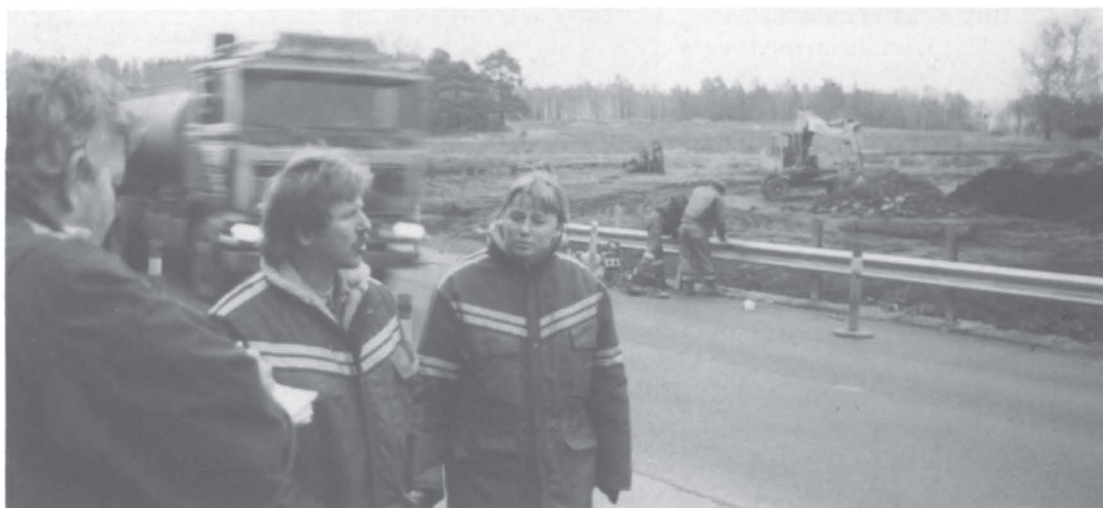
Arbeidet på den trafikkerte Stavernsveien er snart ferdig. Her ser vi fra venstre: Kai Olav Larsen, Morten Roberg og Elin Kristensen.
