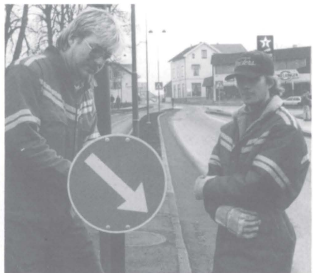
Skiltingen er siste finishen på verket fra Vegvesenets side. Her er det Lasse Støvland og Steven Morgan som skruer opp det siste skiltet i miljøgata.
